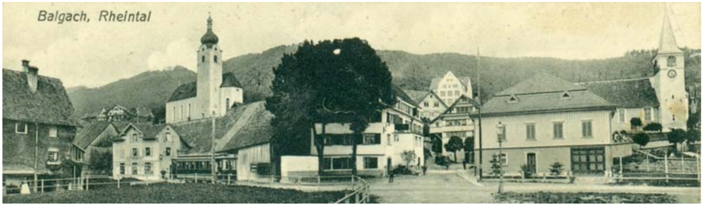
Abb. 3: Links in der Wiese („im Nesslen“) standen bis 1906 mehrere Gebäude, u.a. ein Stadel von Sonderegger. Rechts das 1904 erstellte Oekonomiegebäude von Viehhändler Sonderegger. Aufnahme ca. 1910.
